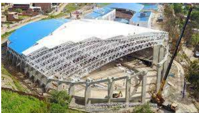
Cubiertas de Odesur - Enabolco
